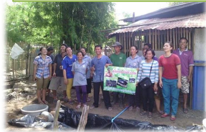
ติดตั้งและใช้งานบ่อก๊าซชีวภาพ
